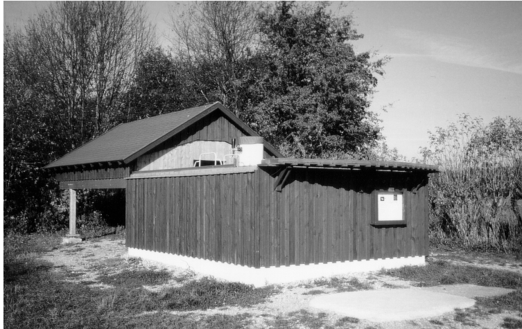
Die Astrohütte der Buchloer mit Schiebedachkonstruktion und Tubus.
